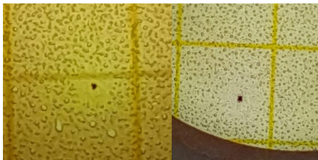
Imagen n°21: Detalle de placa 1a (izquierda); detalle de placa 2a (derecha).
